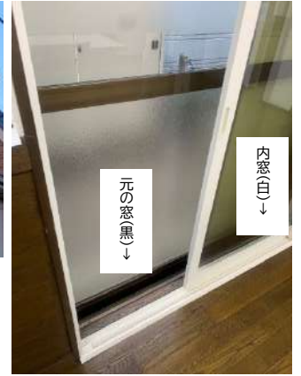
↑窓の断熱化（内窓の設置）
