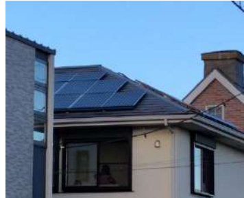
↑太陽光パネルの設置
