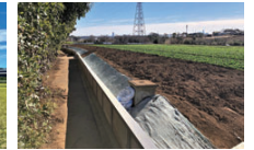
土砂流出防止対策/都筑区
