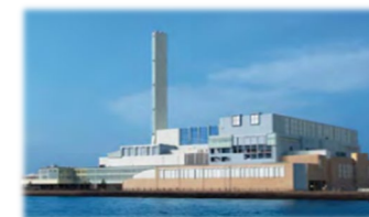
工場の新設・長寿命化工事
